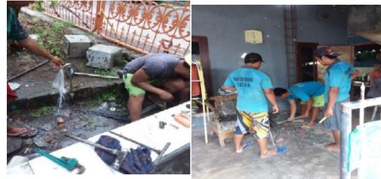
**Gambar 9. Perbaikan Kebocoran Pipa Konsumen**
