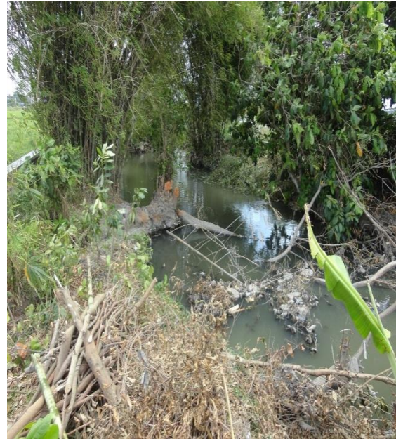
Gambar 4.4 Kondisi sungai unus bagian tengah (Bendung Pesongoran)
