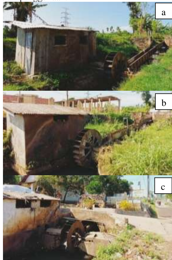
Gambar 4. Kondisi PLTMH PP. Nahdlatut Thalibin (a) Turbin 1; (b) Turbin 2; dan (c) Turbin 3
