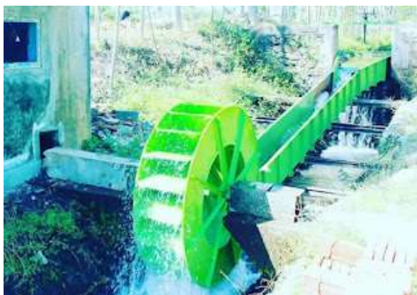
Gambar 3. Foto awal pembangunan PLTMH di PP. Nahdlatut Thalibin
