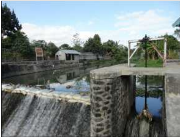
Gambar 1.1 Pendangkalan dan Sampah di Bendung Unus
