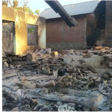
Gambar 1. Sisa Kebakaran Rumah Warga Akibat Konflik Antar Pemuda di Desa Mareje
